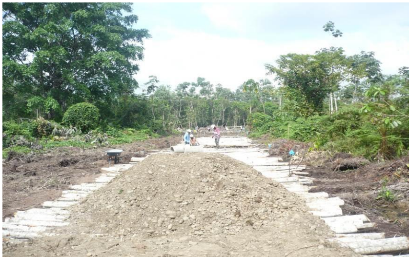
EMPALIZADO Y RELLENO EN MATERIAL DE AFIRMADO – VIA DE ACCESO A OBRA
