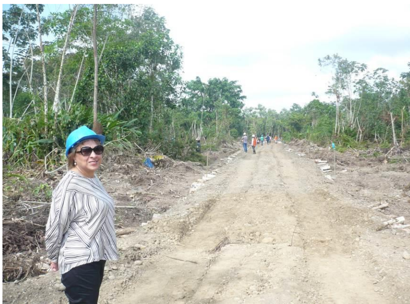
VIA DE ACCESO A OBRA
