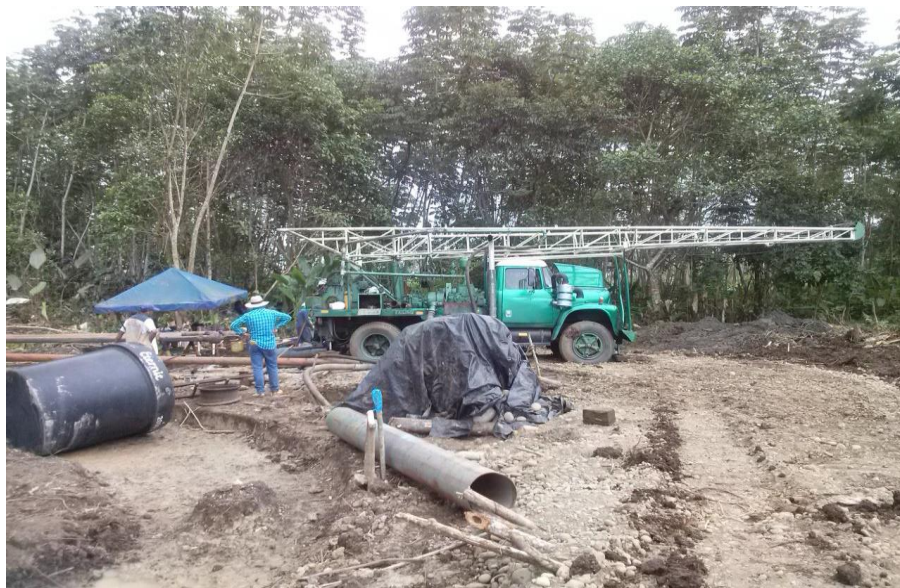
SITIO DE PERFORACIÓN DE POZO
